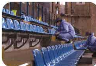
体育館の観客席に施工
