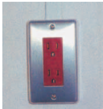
▲各居室に非常用コンセントを設置
