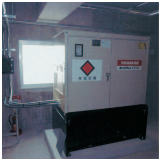
▲非常用自家発電装置
